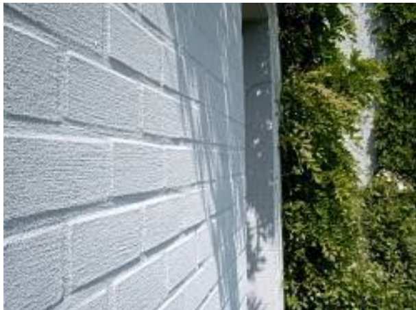
Gevel schilderen met Tensiocoat Quartz (kaleilook systeem)
